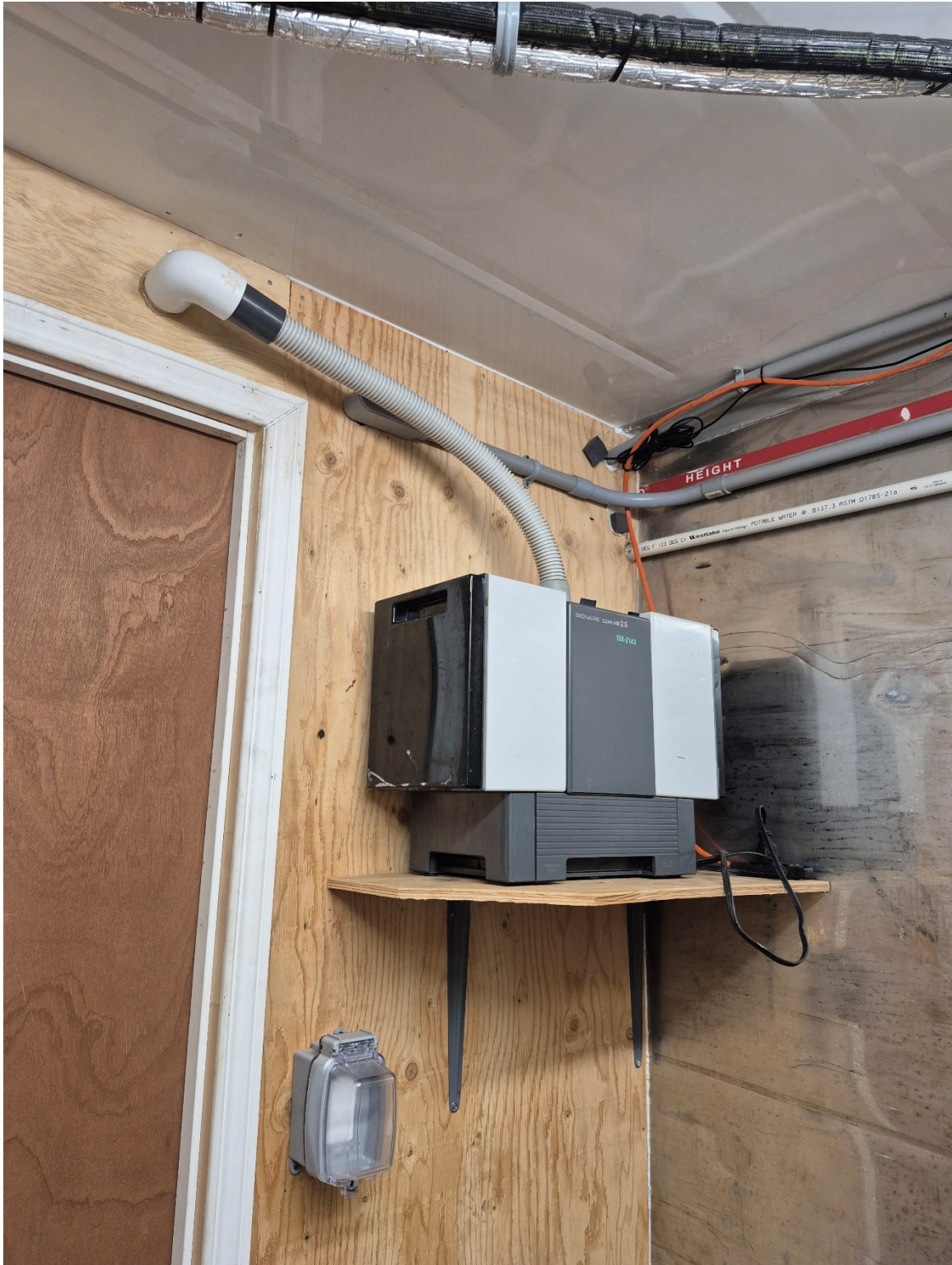
Figure 16 Humidificateur Bionaire à vapeur chaude. L'entretien et le remplissage peuvent se faire du côté SAS sans entrer du côté abeilles. La vapeur est dirigée via un conduit vers la section abeilles
