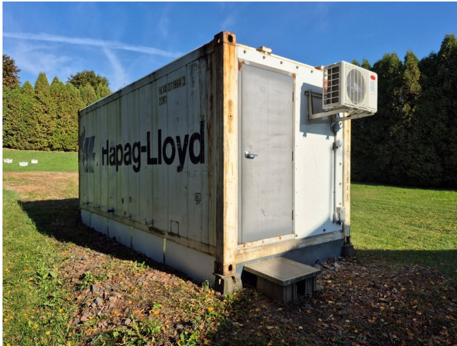
Figure 11 Conteneur maritime usagé adapté pour banques de reines. Le mur visible a été reconstruit pour y insérer une porte d'homme donnant accès au SAS. Le compresseur de la thermopompe est suspendu à ce mur. La base est munie de panneaux bloquant la circulation de l'air pour une meilleur efficacité thermique
