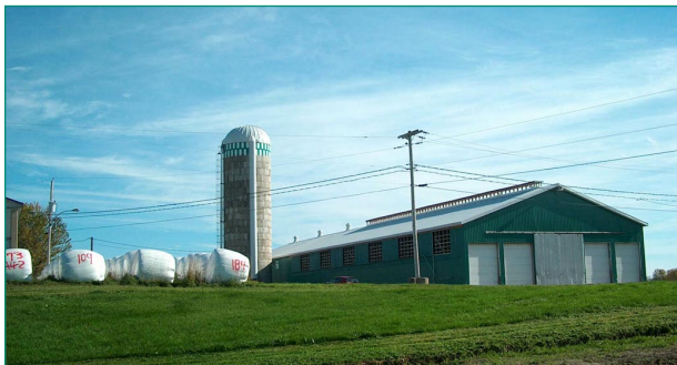
Le nouveau silo à l'étable de bovins de boucherie DC-0172
